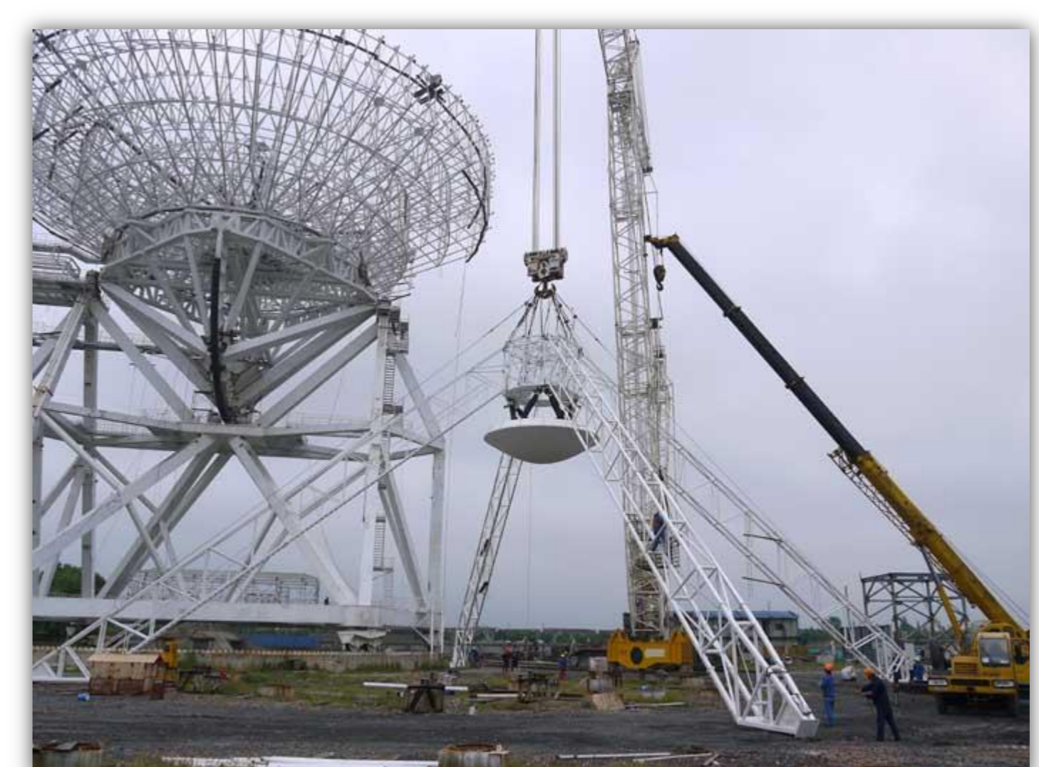
图3 上海现场设备吊装
