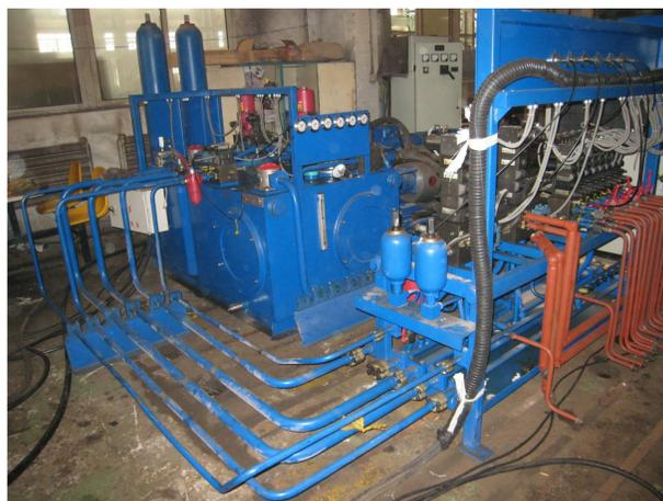
图3 液压泵站及液压阀台现场安装图
